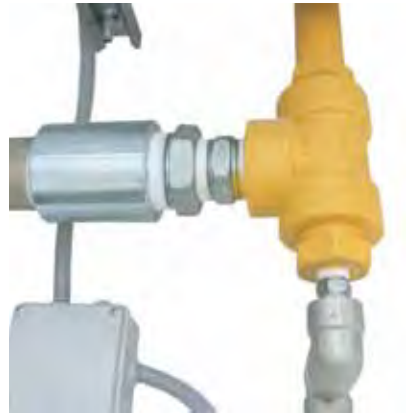
Рис. 22. Внешний вид резьбового соединения, слева направо: коллектор, рестриктор, переход, ниппель, тройник. Далее вверх: переход, трубопровод; вниз: переход, ниппель, отвод
