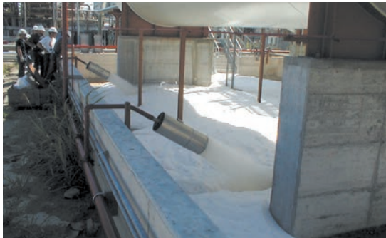
Рис. 8. Вариант установки генератора пены EI-SME
